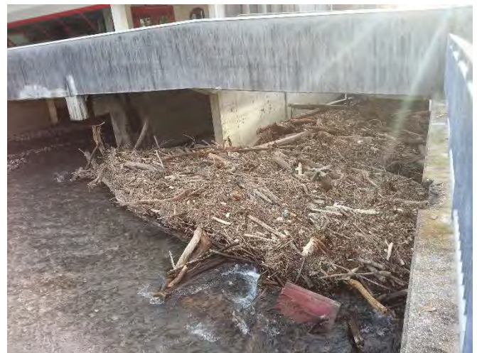
Foto - sx Il Museo Parisi Valle situato nei pressi della foce del torrente Giona – Il torrente è in periodo di magra – fonte CNR-IRPI – dx: Materiale accumulato a seguito di forti precipitazioni in corrispondenza dei pilastri del Museo. (2014)
