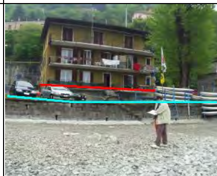
Palazzina al confine con comune di Tronzano – Alluvione 2002 – Fonte immagine: IRPI-CNR In blu il livello raggiunto dalle acque nel 2002. In rosso il livello raggiunto dal lago nel 2000
