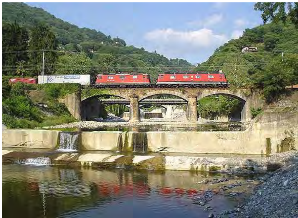
Foto – Passaggio di un treno merci attraverso l'abitato di Maccagno - ponte ferroviario sul torrente Giona
