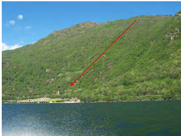
Foto - Centrale idroelettrica di Roncovalgrande, in rosso è segnata la linea delle condotte provenienti dal Lago Delio.
