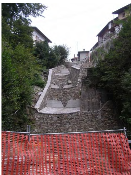
Foto settembre '09– Lavori di messa in sicurezza del Valleggio Valle della Lavina, nei pressi dell'abitato di Graglio (Ovest) e del Valleggione, nei pressi dell'abitato di Graglio (Est).
