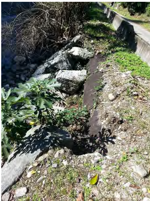
Foto – Sx. Sponde a massciata torrente Giona, segni di cedimento a seguito dell'evento del novembre 2014. Dx. Valle del torrente Giona, abitazioni a ridosso di versanti scoscesi e soggetti ad instabilità
