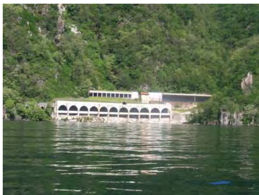
Foto – Gallerie paramassi realizzate in seguito ai fenomeni franosi del 2002
